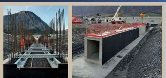
**Cofragem para Galerias Técnicas e Hidráulicas**
